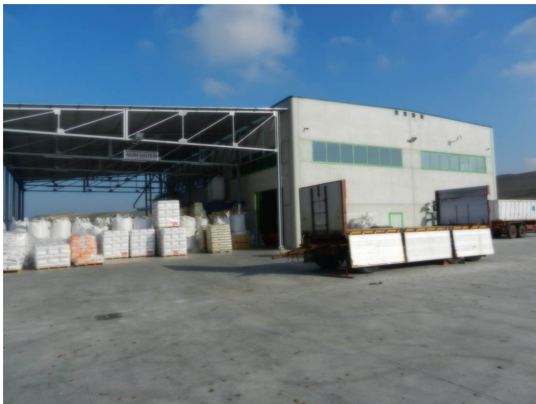
L'area di stoccaggio realizzata con i PSR
